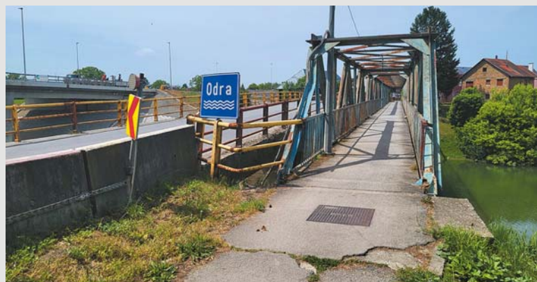
Sisak, stary i nowy most drogowy oraz most dla pieszych
